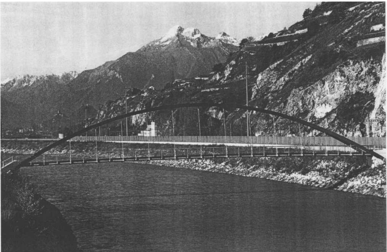
1: Vue de la passerelle depuis la rive droite en amont[ 11.
