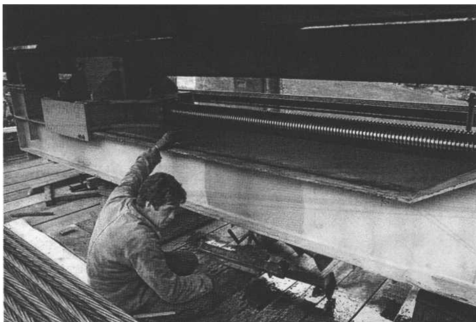
Lavis sans fin d'une course de 2,50 m permet de pousser le pont au-dessus de la gorge.
