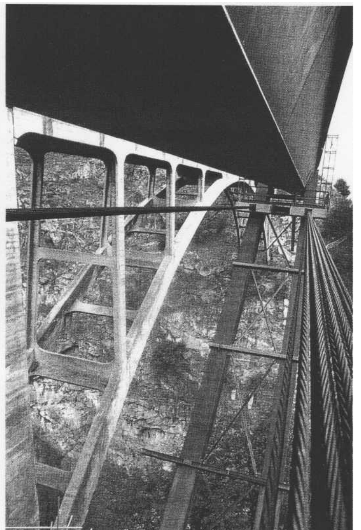
Le faisceau de torons ou la précontrainte d'un pont.
