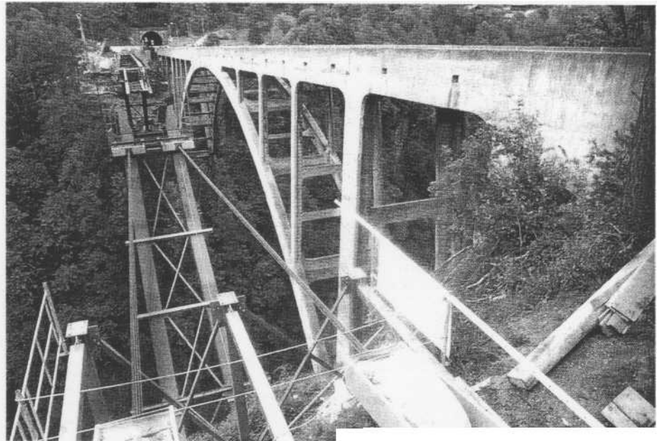
Depuis la rive gauche, le caisson métallique équipé de son avant-bec.
