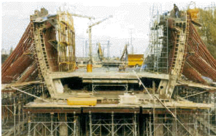
cintrage sur pile
