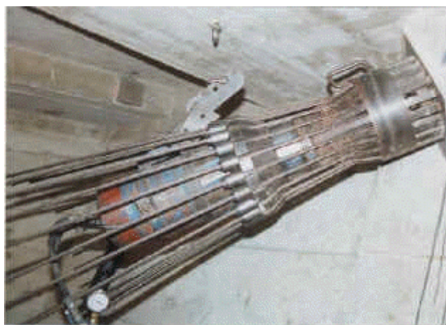
vérin lors de la mise en tension des câbles supplémentaires
