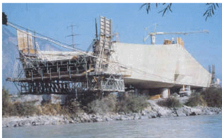
avancement par encorbellement
